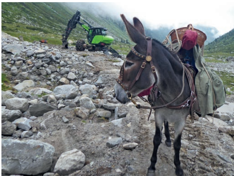
Mit schwerem Gerät werden uralte Wege und Straßen zerstört, um sie für neue Nutzungsarten vermeintlich zu sanieren: Hier: Arbeiten am Krimmler Tauernweg.
